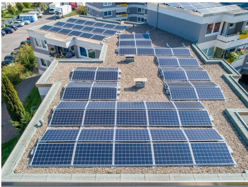
Imagen 1 – Referencia a energía solar fotovoltaica. Imágenes libres, pixabay.
