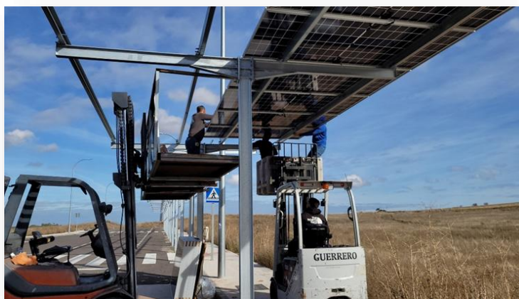
Imagen 20. Instalación de nuevas pérgolas fotovoltaicas en una de las estructuras situadas en la ampliación del polígono industrial de Valverde de Leganés
