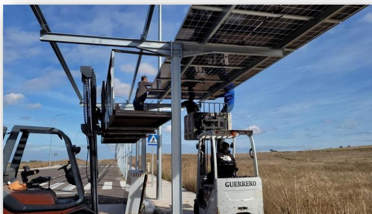
Imagem 20. Instalação de novas pérgolas fotovoltaicas numa das estruturas localizadas na ampliação do parque industrial de Valverde de Leganés.
